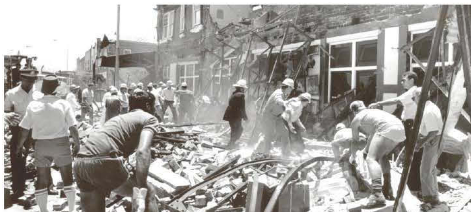
Νιουκάστλ 1989. Μετά τον σεισμό
