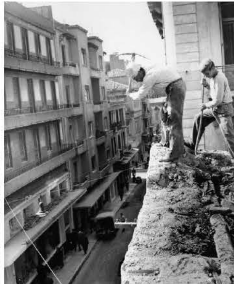
Κατεδάφιση με τον γκασμά.
