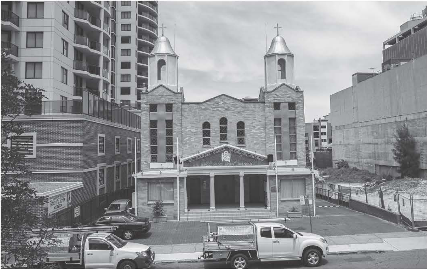
Ο Άγιος Ιωάννης της Παραμάτα. Μια από τις εκκλησίες των Ελλήνων της Αυστραλίας που φιλοξένησε επί δεκαετίες χιλιάδες πιστούς στις χαρές τους και τις λύπες τους. Ο Άγιος Ιωάννης θα καταδαφιστεί αλλά ο σκοπός είναι καλός καθώς η ενορία της Παραμάτα χάρη στη σκληρή δουλειά των ανθρώπων και την πίστη τους στο μέλλον θα αποκτήσει νέα εκκλησία πολύ κοντά στον παλιό ναό.
