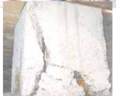
ΣΤΙΣ ΦΩΤΟΓΡΑΦΙΕΣ, (ΠΑΝΩ) το St George Sailing Club που κινδυνεύει με κατάρρευση. (ΔΕΞΙΑ) Μια από τις κολώνες στήριξης με ρήγματα.
