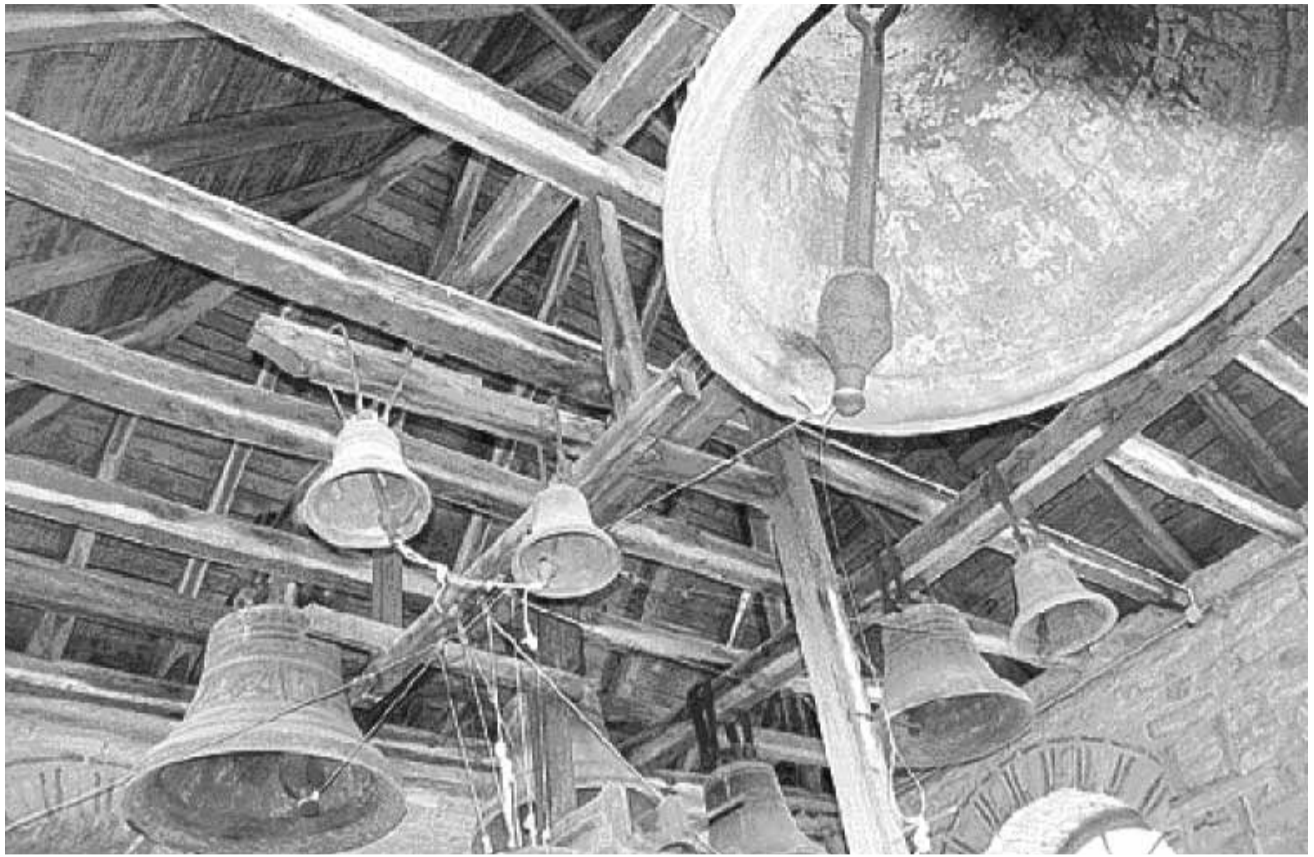
Οι ξύλινες κατασκευές και οι στηρίξεις με ξύλινες δοκούς στο Όρος είναι αξιοπρόσεκτες. Οι νόμοι της στατικής σε θαυμαστή αρμονία με τους νόμους της ακουστικής, είτε εξωτερικά με τις καμπάνες είτε εσωτερικά με τη βοήθεια και των πιθαριών
